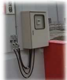
▼ 三菱電機製コントローラー AC-100DL 冷凍機と冷却器を安定制御する為の盤となります。 屋外設置用に当社にて設計致します。
