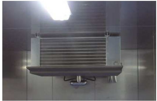
▲ MAXIS社製防爆ユニットクーラー REA-420-2F-6.5-V 特注対応を受付けておりますので御相談下さい。
